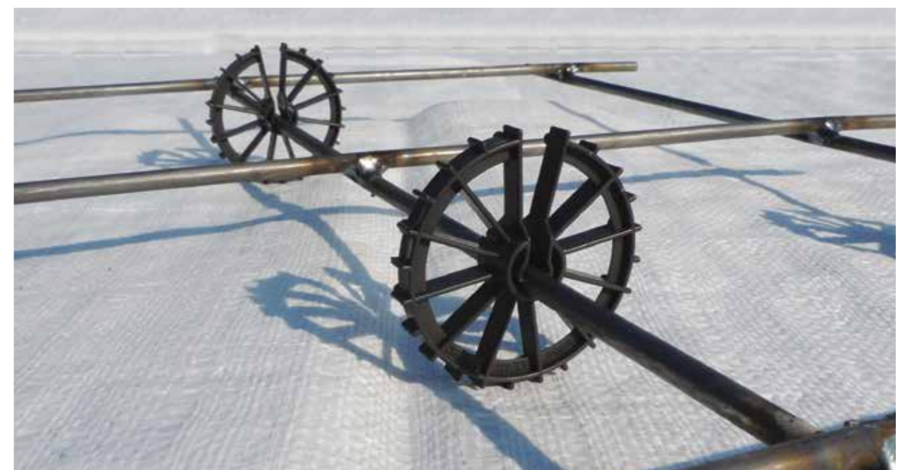
PC용 도너츠 스페이서 시공현장
